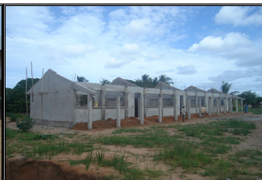
Foto nº 7 Obras de construção da ESG
