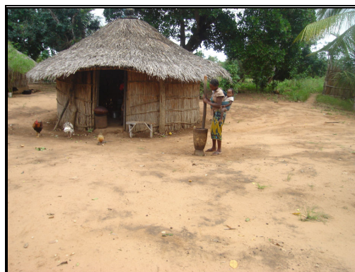
Foto nº 9 Casa de construção precária
