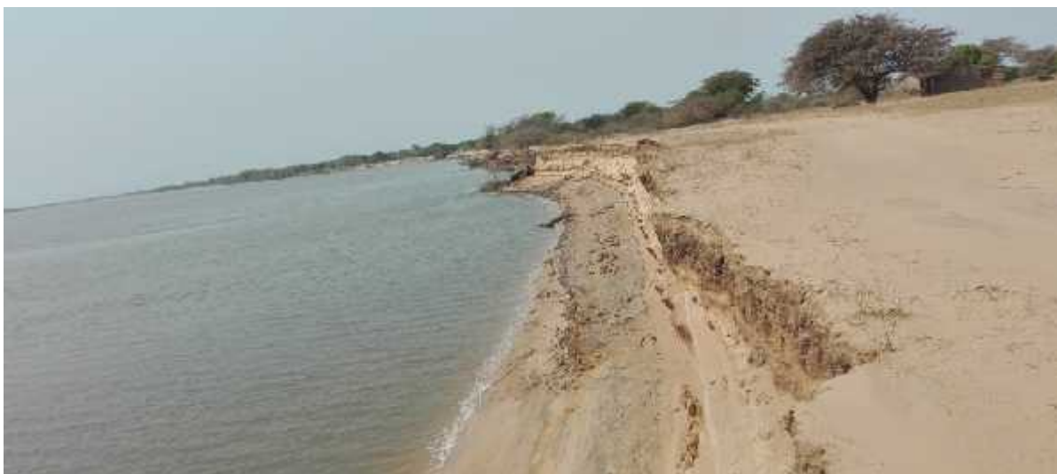
Fig. 4: Efeitos da corrosão das margens do rio Save
