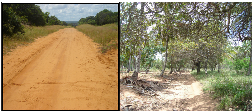
Fig. nº 1 Estradas de terra planada
