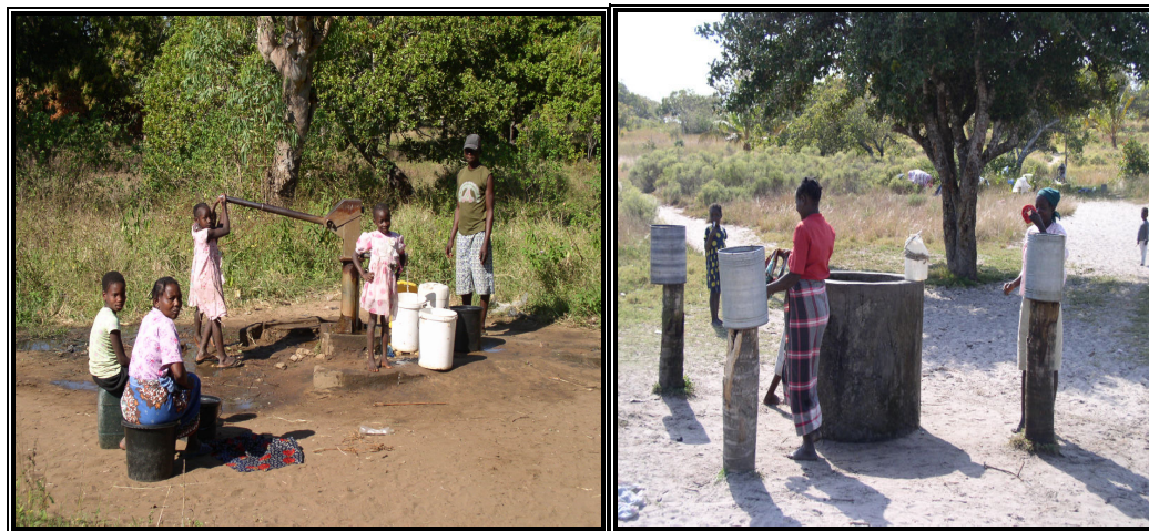
Foto n sistema de abastecimento de água
